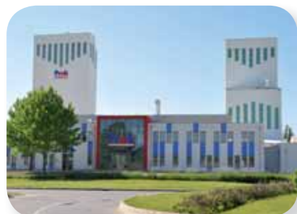
Profibaustoffe Austria GmbH
